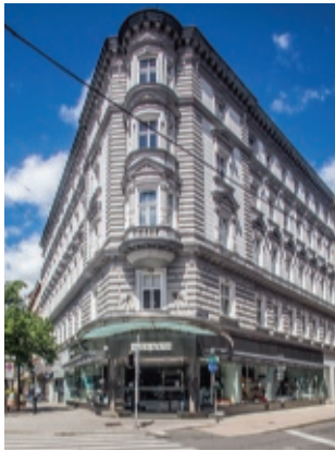
Zinshausprofi Winegg sicherte sich für 11,5 Millionen Euro dieses Eckhaus in guter Lage auf der Wiener Einkaufsmeile Landstraßer Hauptstraße
