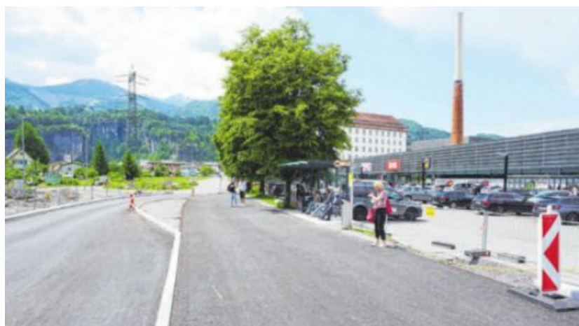
Beim Lünserseepark in Bürs wurde im Zuge der Straßenbaumaßnahmen kürzlich auch eine neue Bushaltestelle errichtet.
