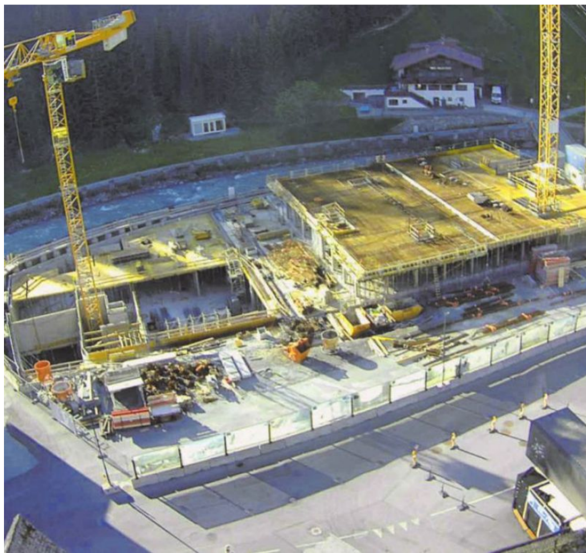
Auf der Großbaustelle zum neuen Gemeindezentrum in der Arlberger Tourismusgemeinde Lech herrscht derzeit Hochbetrieb.
