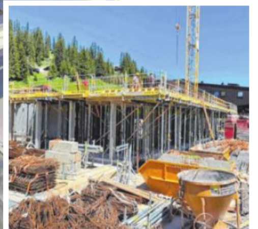
Beton und Stahl wird in Lech tonnenweise verbaut.
