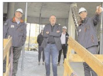
Im Zeitplan. Landeschef Hans Peter Doskozil auf der Spitals-Baustelle in Oberwart. Foto: Medienservice
