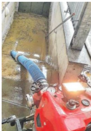
Zahlreiche Keller mussten am Abend ausgepumpt werden.
